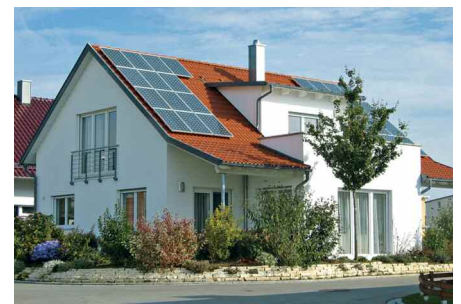
Solarstrom frei Haus: Immer mehr Hausbesitzer entscheiden sich für eine Fotovoltaikanlage.
